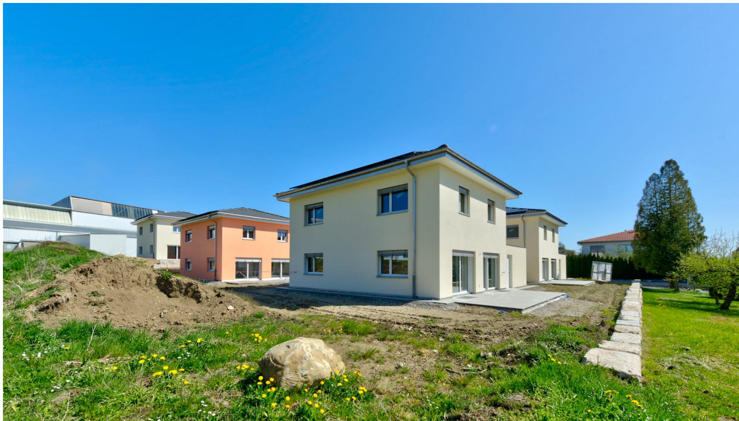
Das Haus 6 im „Edelrohbau“
